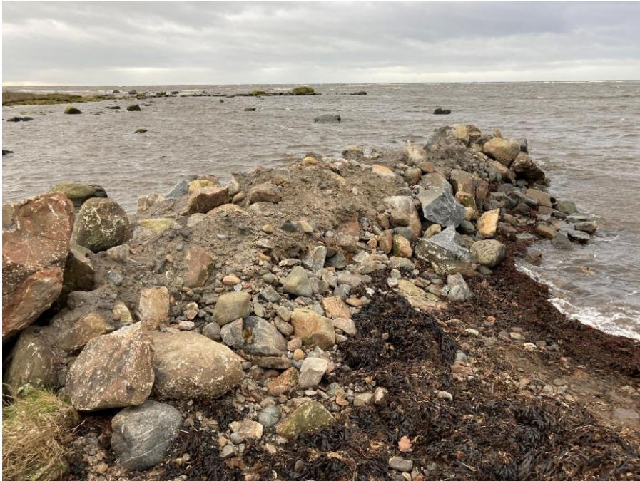
Figur 3. Vågbrytare där sand och grus överst lagts ovanpå och synligt kantstötta stenar till vänster i bild.
